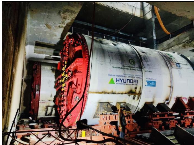
Hình 12: Thi công khiên đào TBM tại tuyến Metro line 3 (Hà Nội)
